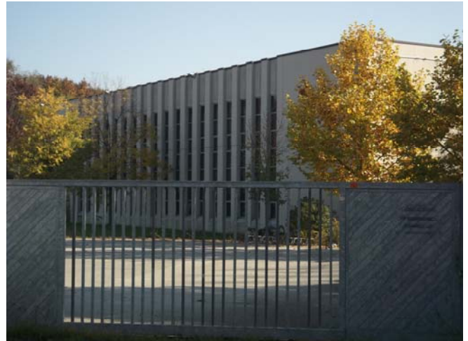
Foto 2 – Ingresso carraio da via Marconi
