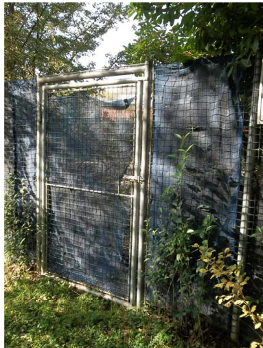
Foto 4 – Ingresso pedonale lungo Fontanile Pantigliate
