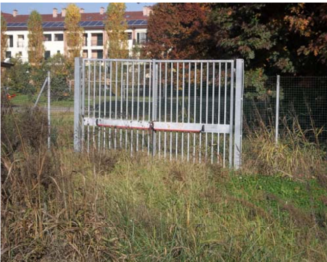
Foto 8 – Ingresso carraiolo lungo lato nord
