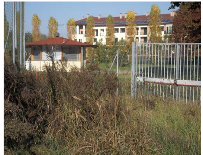
Foto 9 – Ingresso carraiolo lungo lato nord
